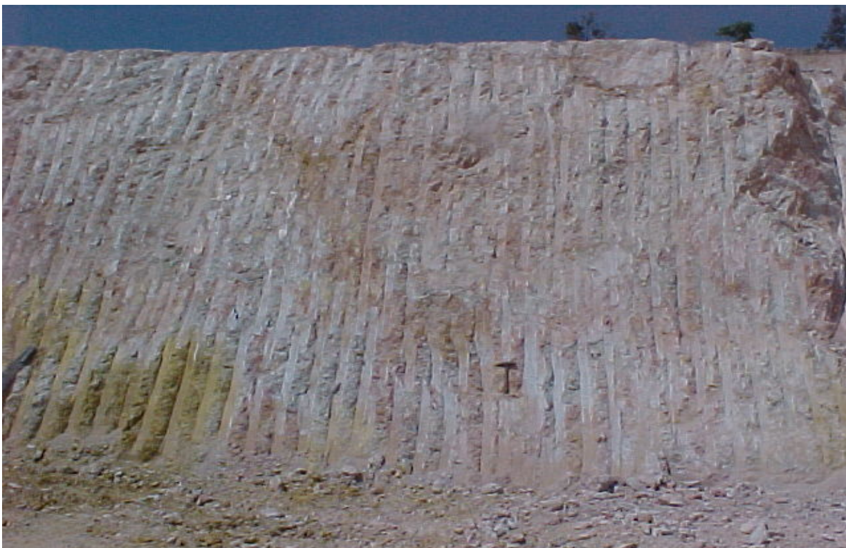
Figura II.6 – Vista do talude da base, exibindo, no canto inferior esquerdo, metalamitos alterados de cor amarela; nas demais áreas predominam tons cremes com vermelho.
